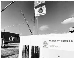
建設中のセリオ本社工場
