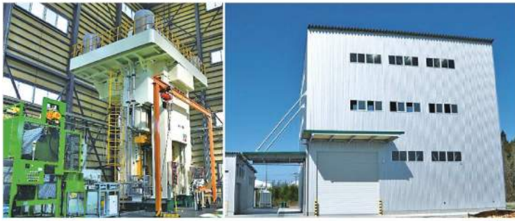
専用建屋と1600ト縦型インパクトプレス
